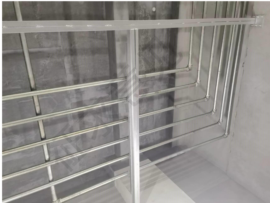
图 3 管网实际布置
